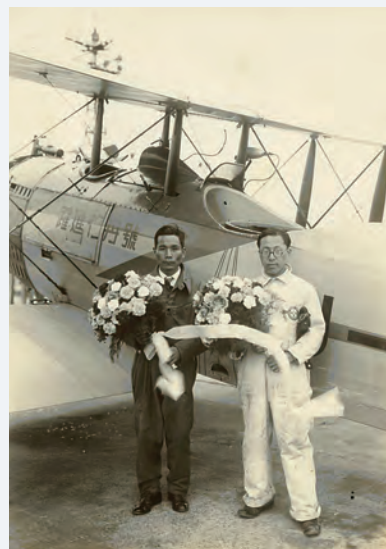
図2 「躍進仁丹号」の側に立つ小森郁雄氏（右）とパイロットの馬道オー氏。後席の側面に放射状に描かれた線は空撮写真のためのガイドラインです。もともと偵察機だったサルムソン2A2は写真撮影に適していたと小森氏は回想しています。
